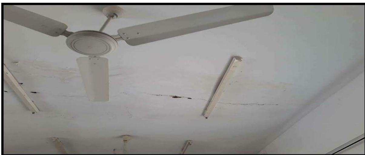
دیمەنیک لە درزەکانى بینای مەلەندى تەندروستى مەیدان
